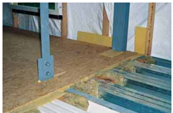
Fotografías de la construcción de Dry Floor en las viviendas sociales de Evreux. Fuente: Arval: Guía de Sistemas de Forjados.pdf .ArcelorMittal: Viviendas Sociales en Evreux. 51 viviendas y una Biblioteca de barrio.pdf. www.arcelormittal.com/sections/es
