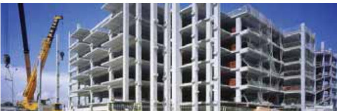
Sistema abierto de pórticos.
