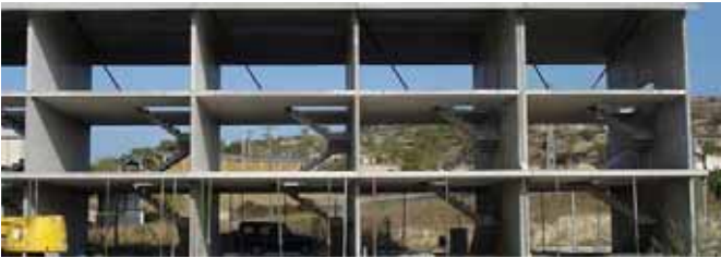
Sistema cerrado de paneles.
