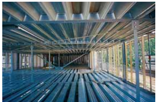
Ilustración de forjado mixto
