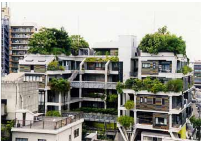
Sistema constructivo soporte-relleno del edificio Next 21, en Osaka.
